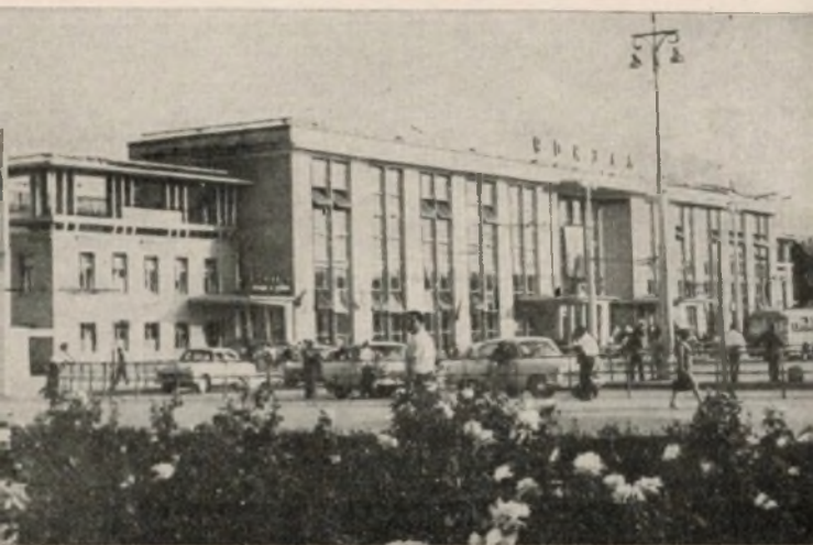
Вокзал после реконструкции.
