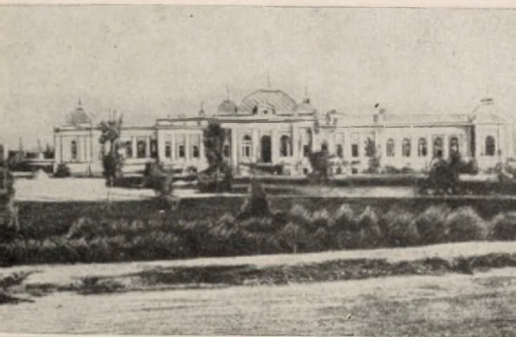
Вокзал до реконструкции.
